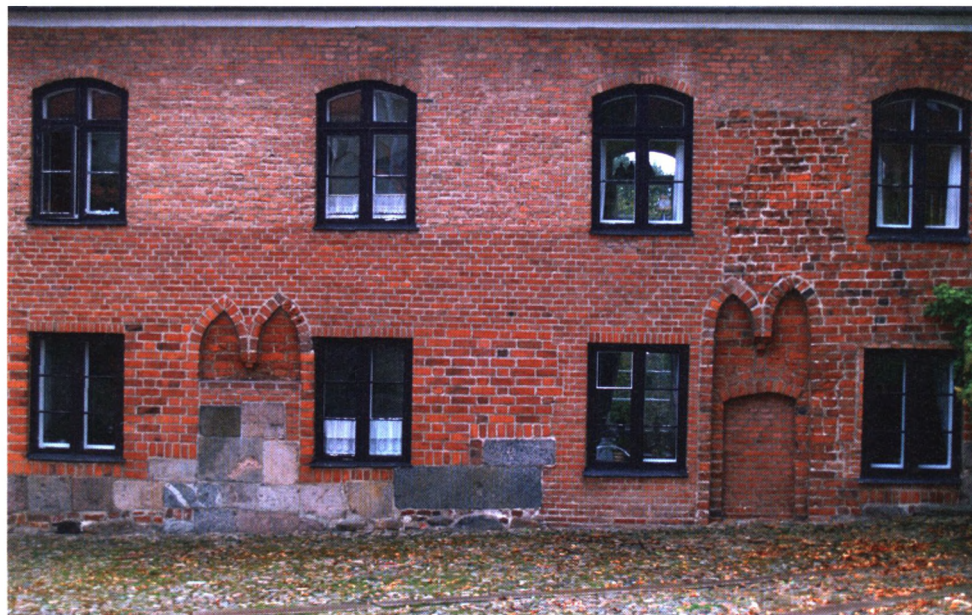
Fig. 22. Udsnit af bygning G's vestfacade med de to tilmurede døre. Foto: HKK 2009.
