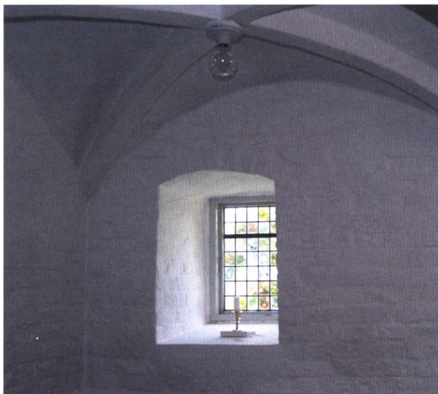
Fig. 39. Vindue i nederste stokværk i østgavlen på bygning K. Vinduesnichen er velbevaret, men der mangler en fals omkring vindueslysningen. Overhvelvningen er sen (1800-tallet). Foto: HKK 2013.
