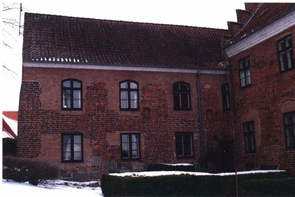
Fig. 17. Bygning G set fra øst. Murværket er præget af mange ombygninger og forskelligt materiale. Hovedparten af soklens genanvendte granitkvadre opfattes som benyttet ved støjens opførelse, og der ses et rulskifte ved overgangen til munkestensmurværket. I underkanten af nutidens store vinduer i andet stokværk, ses de små fladbuede åbninger i tilmuret stand. Foto: HKK 2013.
