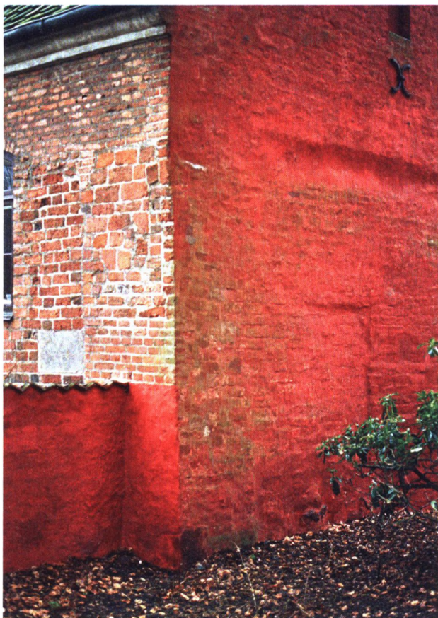
Fig. 21. Den sydligste del af vestfacaden på bygning G med vestmurens afslutning med hjørnekæde op mod den forsvundne mur fra nordfløjen (bygning E2). Foto: HKK 1994.
