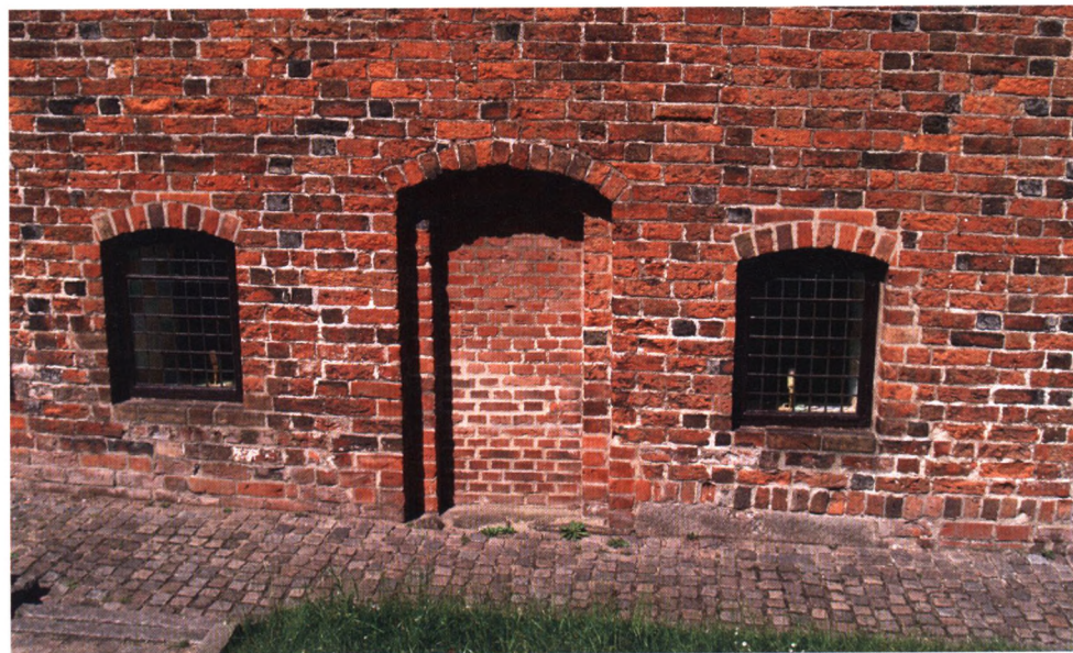
Fig. 38. Vinduer og en tilmuret dør mod syd i nederste stokværk i bygning K. Døren er velbevaret, og der er ingen tvivl om, at den har været flankeret af vinduer. De har blot været lidt mindre end de nuværende. Foto: HKK 2013.
