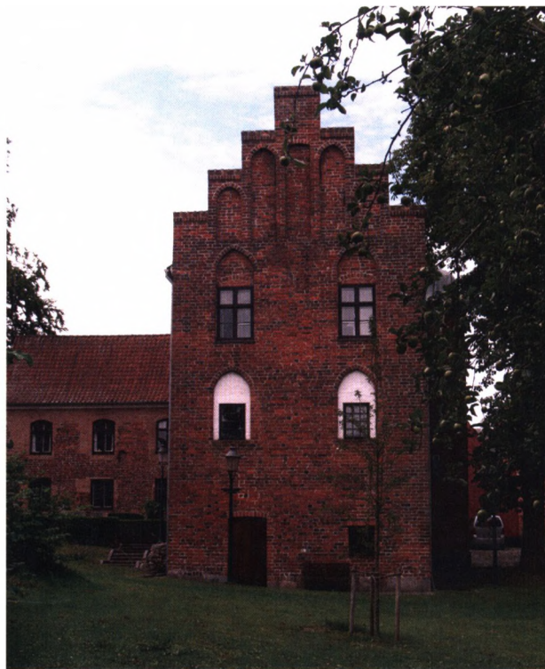
Fig. 45. Østgavlen på bygning K. Set fra øst, er det tydeligt, at bygningen har tre etager. Gavltrekanter virker meget velbevaret, men man vil tro, at den øverste kamtak med skorstenen er ommuret, hvorved den spidsbuede højblænding er gjort fladbuet. Foto: HKK 2013.
