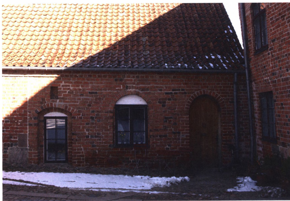
Fig. 28. Bygning I set fra gårdspladsen. Oprindelig var døren til højre et rundbuet vindue, mens det fladbuede vindue til venstre var en dør. Foto: Morten Larsen 2012.
