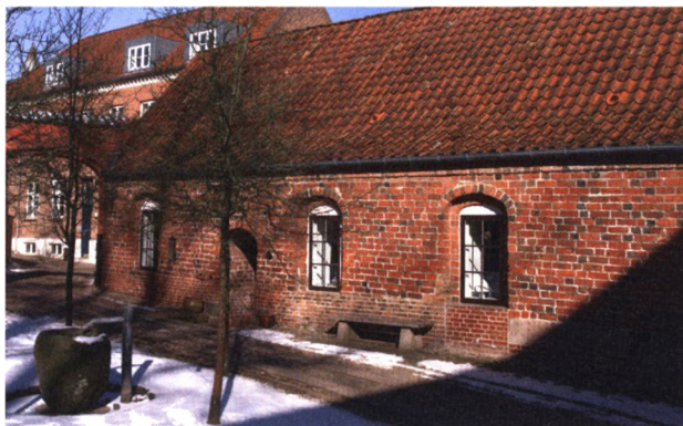
Fig. 25. Bygning H set fra gårdspladsen. Der er tydeligvis sket udskiftning af murværket i bunden med små sten, men også i munkestensmurværket er der foretaget omhyggelige reparationer. Foto: Morten Larsen 2012.
