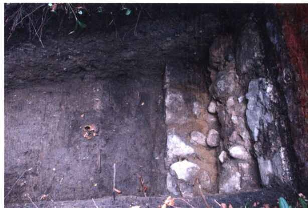
Fig. 12. Den nuværende hegnsmur står på et mindre stenfundament, der består af to skifter store natursten, pakket med mindre sten og lagt i kalkmørtel. Herunder findes et langt kraftigere stenfundament, der består af to skifter store natursten pakket med mindre sten og sand, men ikke kalkmørtel. Sidstnævnte antages at være levning efter midterfløjens nordfundament. Set fra øst. Foto: Lars Agersnap Larsen 2008.
