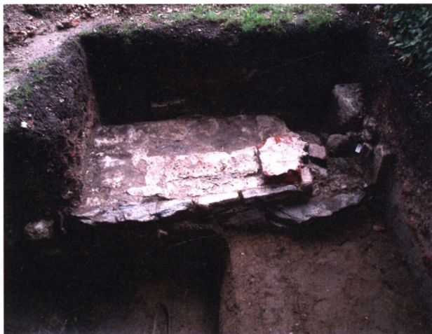
Fig. 19. Østfløjens vestmur set fra østre korsgang. Længst til højre to kvadersten og indvendigt et spor efter en niche. Foto: Jesper Hjermind 2010.
