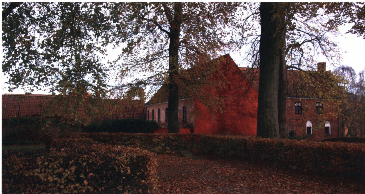
Fig. 2. De bevarede klosterbygninger set fra syd. Foto: HKK 2017.
