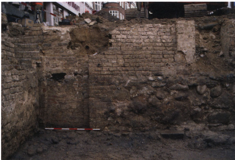
Fig. 7. Et udsnit af kælderens sekundære sydmur, set fra nord, og med den blændede døråbning østligst. Det stenlagte gulv foran sydmuren stammer fra kælderens funktionstid i 1600-1700-tallet. Øverst mod øst ses en spindeltrappe fra 1800-tallet, som ender højt over det ældre gulv. Det skyldes, at gulvniveauet i kælderen var hævet væsentligt i bygningsens seneste brugstid. Vestligst ses en gennembrudt døråbning ligeledes fra 1800-tallet. Foto: Aalborg Historiske Museum.
