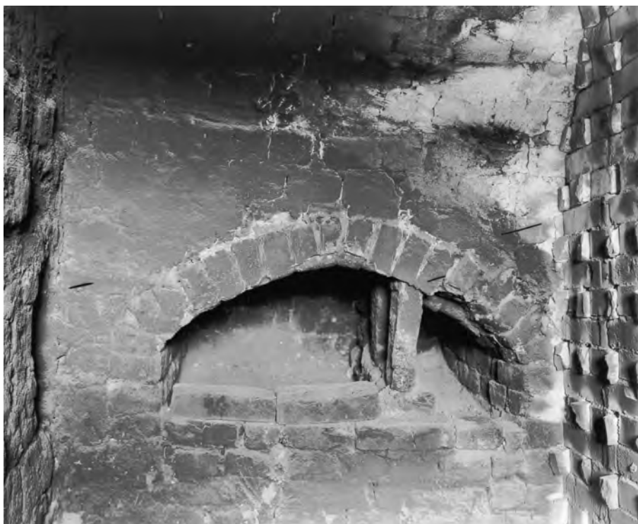
Fig. 18. Blyovnen i skorstenen på den af Frilandsmuseet hjemtagne pottemagerovnen fra Sorring. Ovnene virkede som en flammeovn, hvor blyet lå i det lave bassin til venstre, og ilden var til højre. Flammerne slikkede ind over blyet og smeltede det. Ved siden af på væggen hang rageren af jern, som blev brugt til at skumme blyasken af med. Til højre ses den risteagtige bagvæg, kaldet skættelen, i ovnkammeret. Ved at lægge større eller mindre sten ind i hullerne kunne man i nogen grad regulere trækket i ovnen. Jf. fig. 19. Foto: Kai Ulldal, Frilandsmuseet, 1946.
