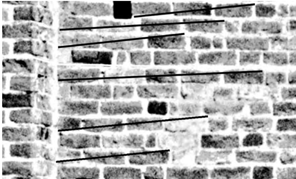
Fig. 4. Byggnadstekniska faktorer inverkar på löpens antal. Exemplet är från hörnet mellan strävpelaren och den norra delen av långhusets västra vägg. Linje = löpare. Rätäläinen 2000.
