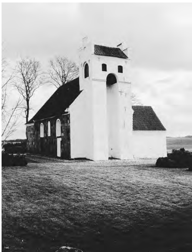
Fig. 1. Styltetårnet ved Mesing Kirke syd for Århus, opført over to piller ved skibets vestgavl. Foto: Th. B. 2002.
