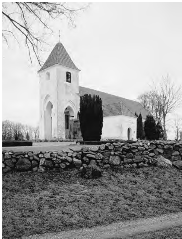
Fig. 2. Styltetårnet ved Voer Kirke syd for Randers fjord, opført over to fritstående piller. Foto: Th. B. 2002.
