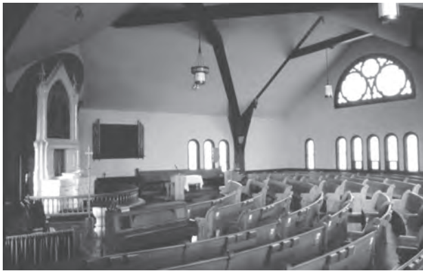
Fig. 14. Fra alle plasser i Koshkonongs kirke opplever men det svevende bjelkekorset oppunder himlingen. Benkeplassene i bue ble mer og mer utbredt i amerikanske kirker gjennom siste halvdel av 1800-tallet, mens den diagonale organiseringen av kirkerommet var langt mindre vanlig. Foto: JCE 2004.
