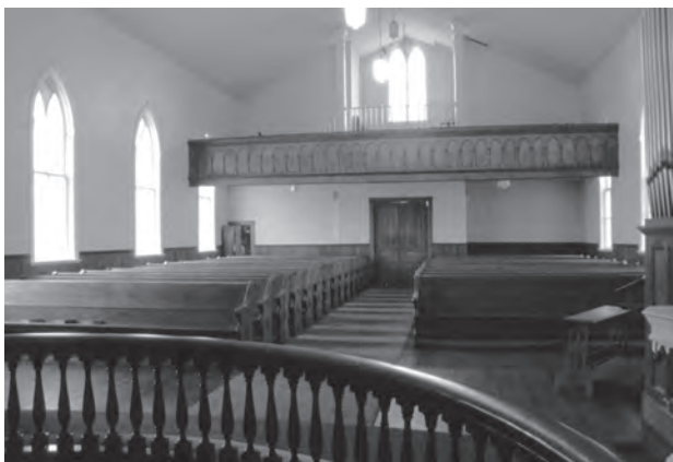
Fig. 4. Bare benkene og galleribrystningen har fått litt utsmykning. Dvergarkaden med spissbuer på brystningen er vanlig gjennom de siste ti-årene av 1800-tallet i hele den sydvestlige delen av Minnesota, ikke minst i svært mange av de norsk-amerikanske kirkene. Foto: JCE 2004.
