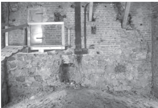
Fig. 10. Sakristians vindsvåning. Södra väggen. Foto P.O. Welin 1977. Museiverkets bildsamlingar, Helsingfors.
