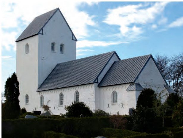
Fig. 6. Teglstenskirken i Bindslev. Kirken afviger lidt fra hovedparten af den vendsysselske teglstensgruppe ved, at der kun er liséner på hjørnerne forbundet med mange bueslag under gesimsen. Koret i Bindslev kan dendrodateres til 1190. Foto: HKK 2007.
