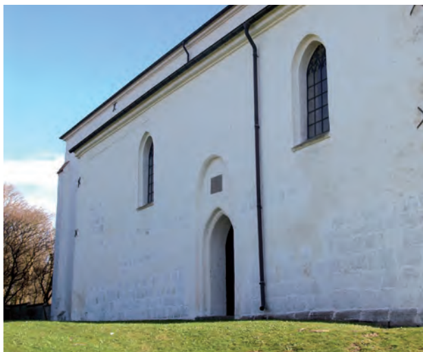
Fig. 8. Nordre sideskib set fra nordvest. Det ydre er helt glat og vinduer og døre står som markante åbninger i den glatte flade. Under kalken kan man ane de mange genbrugte granitkvadre. Foto: HKK 2006.
