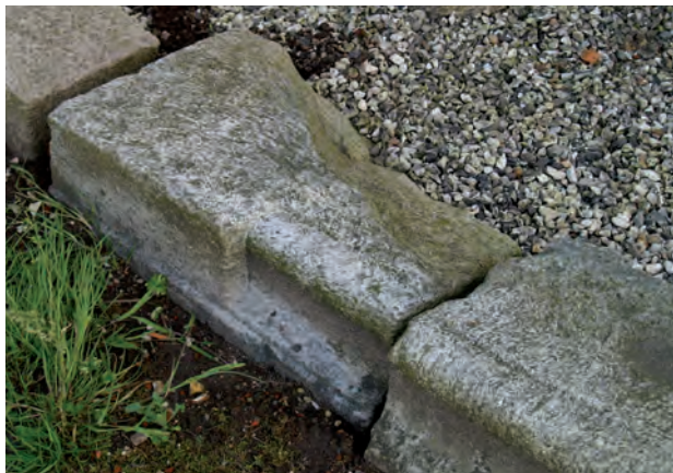
Fig. 4. Sokkelsten med hjørnelisén, 41 cm på hvert led. Muligvis er det i virkeligheden en sten, Chr. Zeuthen fandt på plads i 1862 på nordre korkapels nordøsthjørne. Nu udlagt ved markeringen af den forsvundne korsarm i nord. Foto: HKK 2007.
