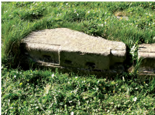
Fig. 3. Kvader fra apsidens øverste sokkelskifte med plint fra en 41 cm bred lisén. Nu udlagt i markeringen af den forsvundne apside. Foto: HKK 2006.
