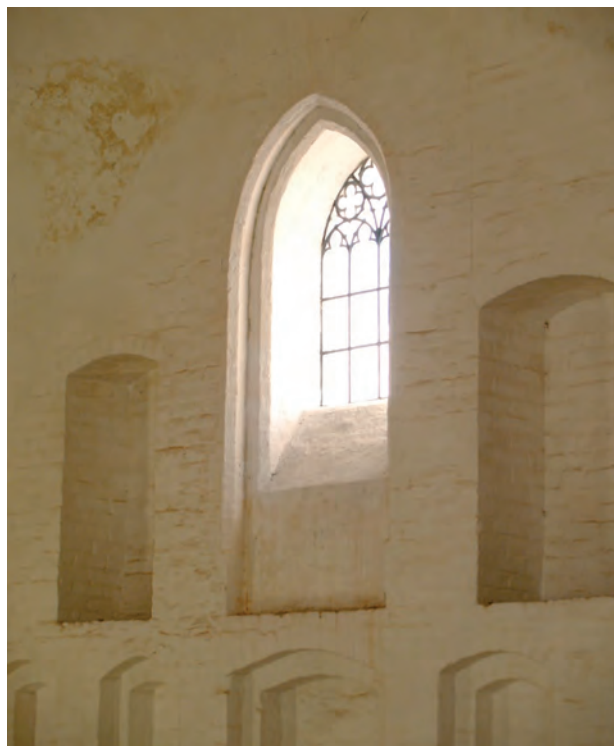
Fig. 10. Højkirkevindue i syd. De to højkirkevinduer er overordnet set ens med det spidsbuede vindue placeret i et blændingsfelt med lavtsiddende bund. Der er dog visse forskelle, så som hvorvidt falsene er afrundede eller affasede. Foto: HKK 2007.
