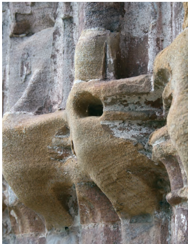
Fig. 7. Vederlag med monteringshul i portalen fra korsgangen ind til refektoriet i Fountains Abbey, Yorkshire. Foto: MWJ 2010.
