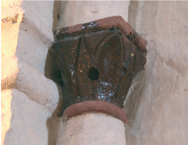
Fig. 3. Den østre kapitæl i lægbrødrenes portal. Det runde hul løber gennem hele kapitælen. Foto: MWJ 2011.
