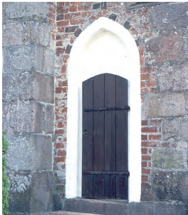
Fig. 14. Prydskifte af vekselfarvede teglsten om trappehusdøren til Ølgod Kirkes senmiddelalderlige tårn. Det omkringværende afrensede murværk er udført af røde sten og spredte mørke bindere. Foto: Th.B. 2005.
