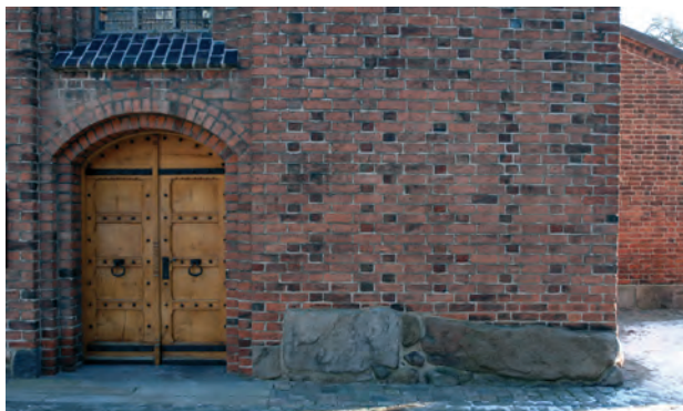
Fig. 12. Udsnit af vestfacaden på Svendborg Sankt Nicolais tårn. Murværket er omsat ved restaureringen i 1892-94, ledet af H.B. Storck med J. Magdahl-Nielsen som konduktør. Bemærk de mørke bindere – der har fundet en sortering af stenene sted. Foto: KLR 2012.
