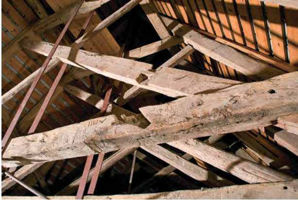
Fig. 8. Nordre korsarms middelalderlige tagværk har flere nyere reparationer af både fyrretræ og genanvendt egetømmer. Den karakteristiske svungne udskæring på det vandrette hanebånd i forgrunden fortæller, at der er tale om et genanvendt spær (sammenlign med Fig. 9). Set mod sydøst. Foto: Arnold Mikkelsen, Nationalmuseet 2011.
