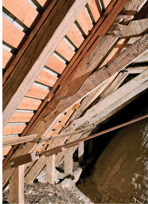
Fig. 9. Sydsiden af nordre korsarms tagkonstruktion med kunstfærdige udskæringer til krydsbånd og hanebånd. I forgrunden ses et trækbånd af jern, der formentlig er opsat i 1900-tallet som ekstra afstivning. Set mod nord. Foto: Arnold Mikkelsen, Nationalmuseet 2011.
