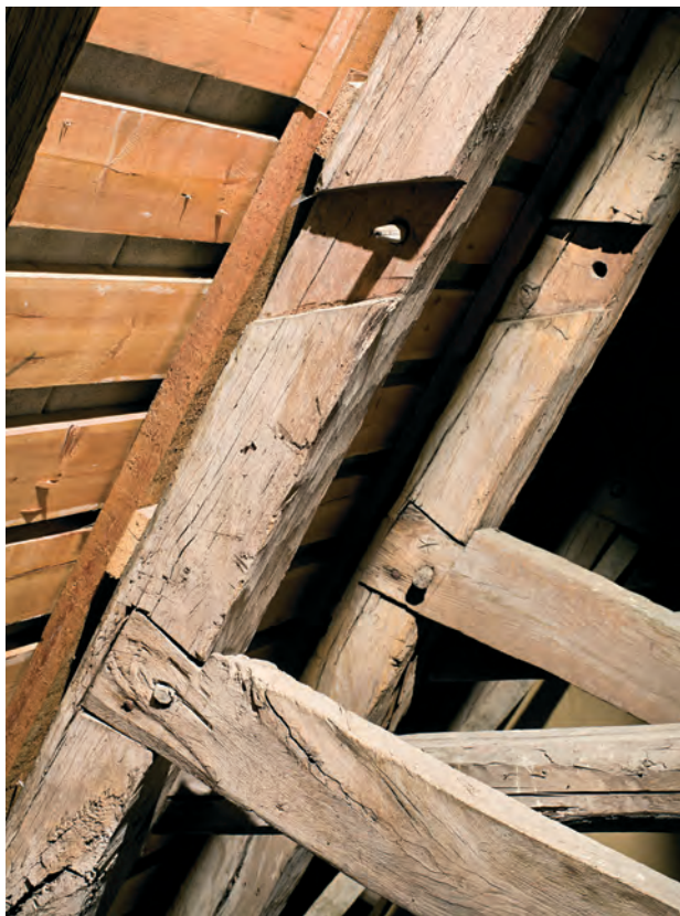
Fig. 7. I midtskibet er tagkonstruktionens øvre hanebånd fjernet, men udskæringer i spærene viser deres oprindelige placering. Nedenunder er de skrå krydsbånds øvre ender fastgjort til spærene med svalehaleformede bladninger. Set mod øst. Foto: Arnold Mikkelsen, Nationalmuseet 2011.
