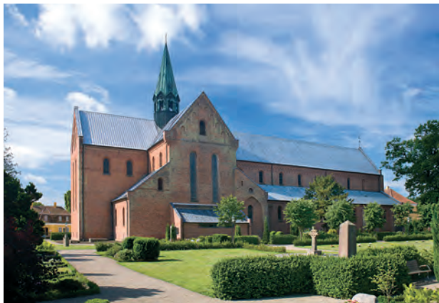
Fig. 1. Sorø Klosterkirkes nordside. Det lange midtskib, nordre sideskib og nordre korsarm har bevarede middelalderlige egetagværker. Foto: Arnold Mikkelsen, Nationalmuseet 2011.
