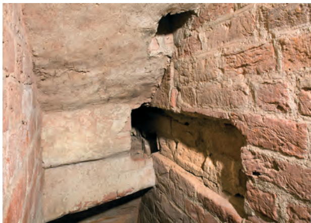
Fig. 10. Midtskibets første tagkonstruktion gik tabt ved branden i 1247, men øverst i trappeskakten til loftet på klosterkirkens sydvestre hjørne har det vestligste spærfag efterladt spor i murværket. I det vandrette hul har ligget en spærsko forbundet med en kort spærstiver, der har afsat hul i loftet. Foto: Arnold Mikkelsen, Nationalmuseet 2011.
