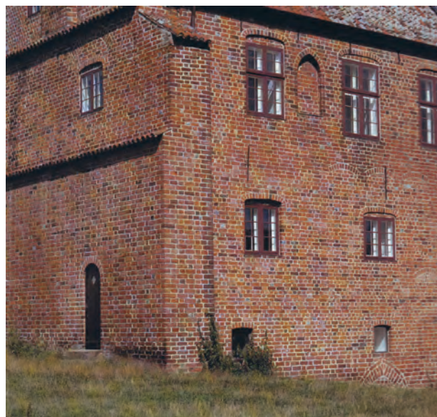
Fig. 14. Den bevarede middelalderbygning i Esrom set fra sydvest. Det ses, at gavlen er en del af østfløjens oprindelige østmur med etagespring på inder-siden. I øvre stokværk anes over vinduet et rundbuet stik fra en dør, der har ført ind i udløberfløjen. Heri ses lige over jordsmonnet toppen af stikket over en spidsbuet åbning, hvorigennem en kanal har løbet. Foto: HKK 2004.
