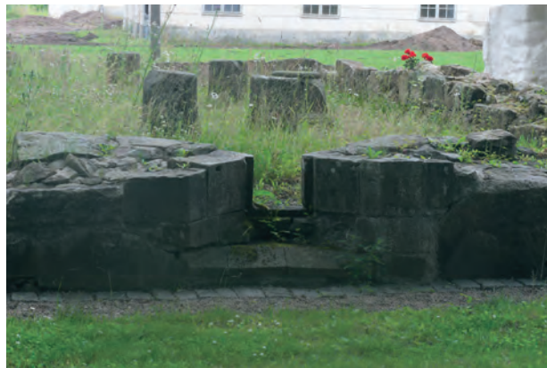
Fig. 12. Bunden af et vindue i Herrevad Klosters østfløj. Det præcist udformede vindue med smig og glasfals må stamme fra kapitelsalen. Foto: HKK 2012.
