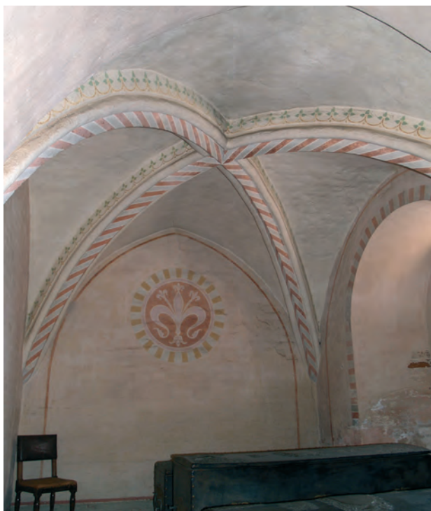
Fig. 9. Ribbehvælvet i armariet i Sorø set mod syd. Til højre ses nichen omkring den senere tilmurede dør ud mod korsgangen. Foto: HKK 2011.
