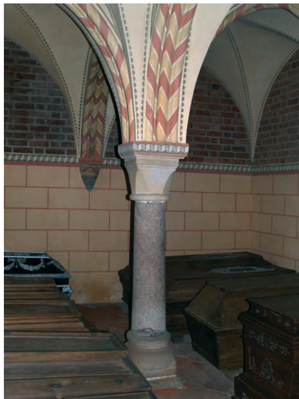
Fig. 8. Søjlen, der bærer de fire grathvælv i sakristiet i Sorø. Søjleskafet er af granit, mens base og kapitel er af skånsk sandsten. De markante jordbuer svarer til profilet i ribberne i armariet. Foto: HKK 2011.
