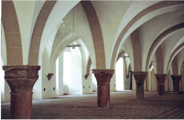
Fig. 5. Lægbrøddormitoriet i cistercienserklostret Eberbach ved Rhinen. Dormitoriet med grathvælv er dateret til midten af 1100-tallet og således lidt ældre end østfløjen i Sorø. Nogenlunde således kan man forestille sig munkedormitoriet i Sorø. I tidens løb er gulvet i dormitoriet i Eberbach hævet lidt, hvorfor baserne er blevet skjult. Efter Ruffer 2008.
