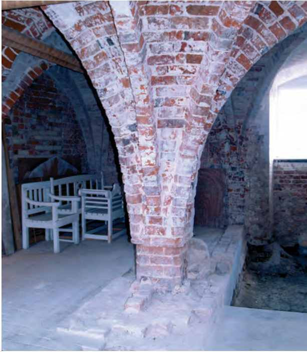
Fig. 26. Pille i kapitelsalen i Holme Kloster. Gulvet i venstre side (mod nord) er et resultat af en meget betydelig terænhævning. Til højre ses en udgravning, hvor man formentlig har ledt efter det oprindelige gulv, men hvor man af uvisse grunde er stoppet ved toppen af vægbænken. Udgravningen synes ikke registreret af nogen museumsmyndighed. Foto: HKK 2009.
