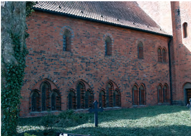
Fig. 19. Østfløjen i Løgum set fra øst. Ud fra vinduesformerne kan man aflæse, at der forskellige rum bagved, og at disse er tillagt forskellig betydning. Kapitelsalens tre vinduer er tydeligvis fremhævet. Foto: HKK 2007.
