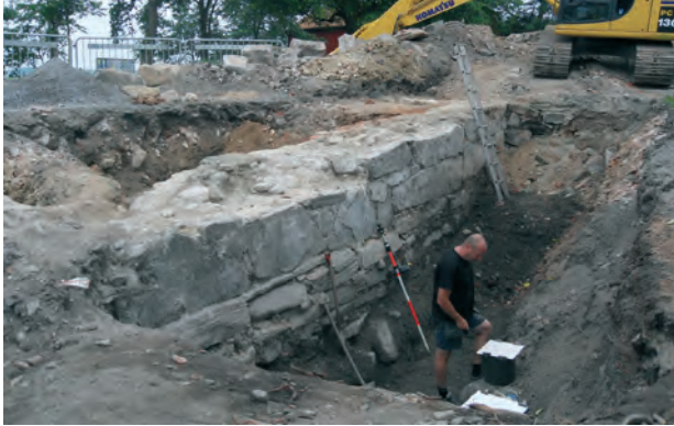
Fig. 28. Udgravning i Ås Kloster. Den kraftige mur i midten er tilbygnings nordmur, mens lidt af østfløjens østmur ses til højre under gravemaskinen. Foto: HKK 2011.
