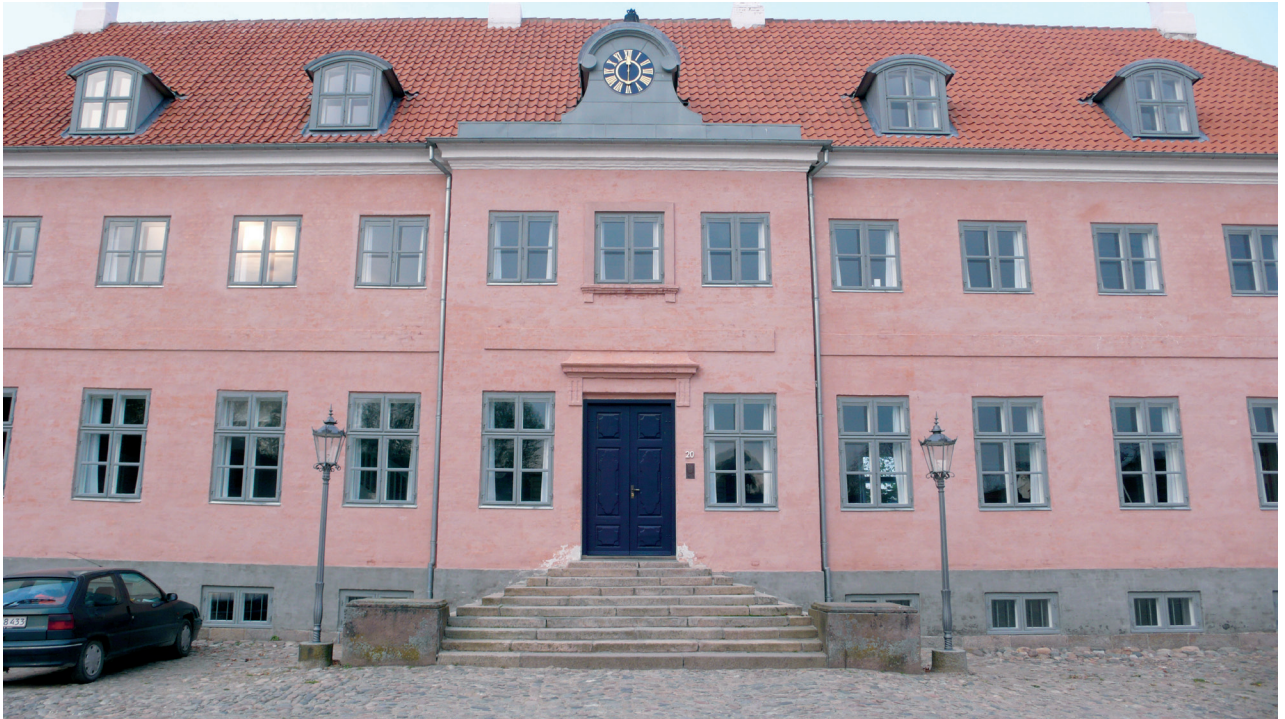
Fig. 1. Undersøgelsen af denne bygning viser at hele facaden oprindeligt har haft en monocrom farveholdning. Ved restaureringen valgte man at give hovedgæns og sokkel afvigende kulører, hvilket i høj grad slører opfattelsen af trappens tre løb samt de karakteristiske hippopulter eller mountingposts i hvert hjørne.
