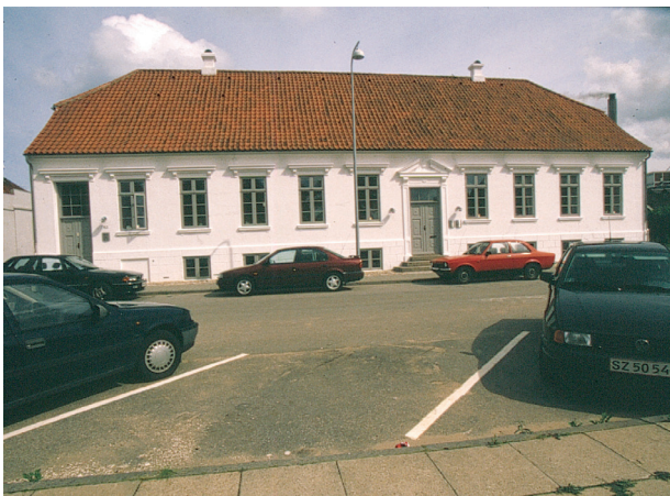
Fig. 2. Denne bygning havde før restaureringen en sorttjæret sokkel, der gik op over kælder vinduerne. Ved restaureringen blev hele facaden ensfarvet, hvilket fremhævede trappe og indgangsparti.
