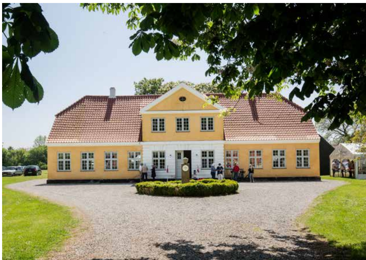
Fig. 1: Køng Museum er indrettet i Gl. Øbjerggaard, som var bygget i 1780 til bolig for inspektør Christian Voelker og som administrationsbygning for Kjøng Fabrik. Den blev istandsat og indviet til museum i 1999. Foto: Poul Christensen 2021.
