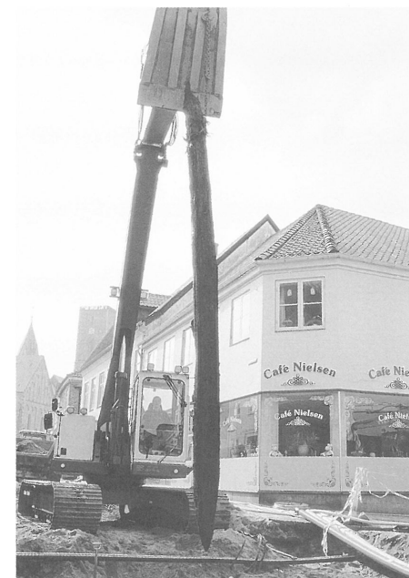
Fig. 4. Den næsten 5 m lange piloteringspæl har formentlig båret en træbelagt vej. Pælen er fældet omkring 1326. Foto: L. Andersen.
