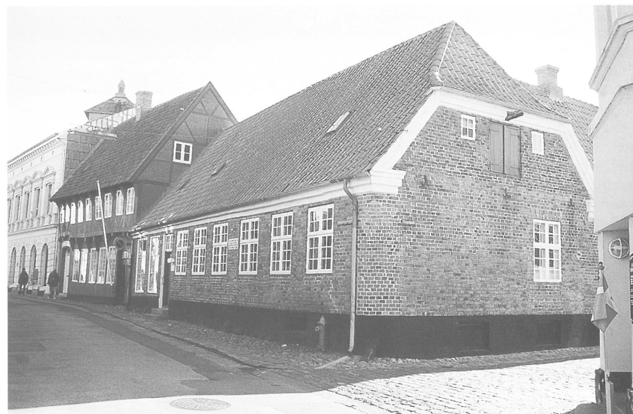
Fig. 3. Grundmuret hus fra 1847 i Sønderportsgade 3 i Ribe, "Maren Spliids hus". Foto: Lis Andersen.
