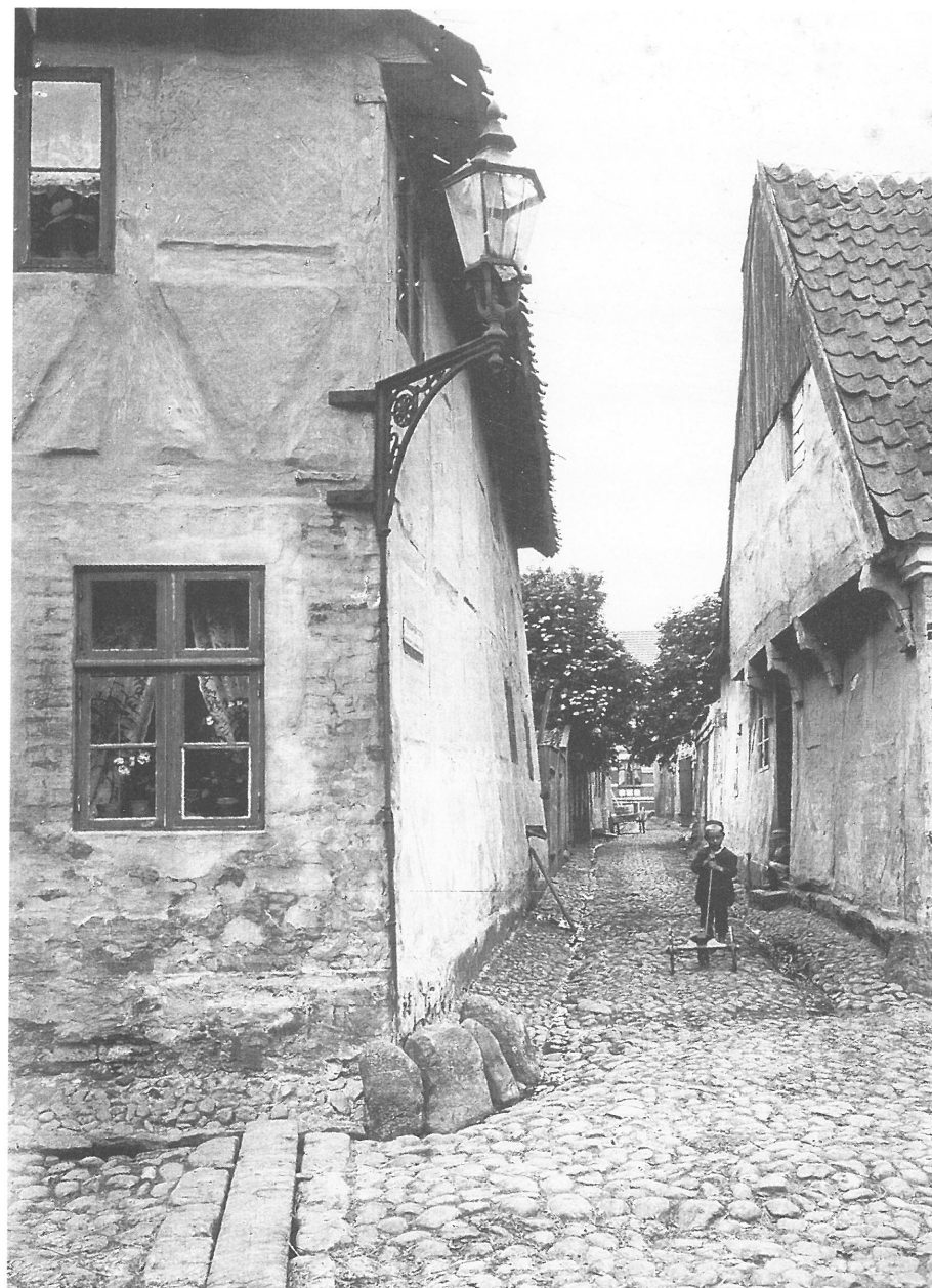
Fig. 5. Som det fremgår af dette foto, der er ældre end fig. 4, har der ikke været nogen falsk bjælkeende over knægten på hjørnet mod Fiskergade. I stedet understøtter knægten tagremmens udkragede ende. Foto i Antikvarisk Samling.
