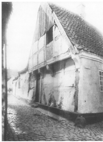
Fig. 4. Foto fra før Axel Hansens ombygning. Der er ingen stolpe i fag nr. 2, men derimod et løsholt mellem de flankerende stolper. Derfor er der heller ingen spor i overgangsfodens underside efter en falsk bjælkeende. Over løsholtet - der sidder lavere end de øvrige - har der formentlig været et vinduesparti. Foto i Ribe Lokalkarkiv.
