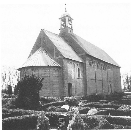
Fig. 1. Hvidding kirke. Byggematerialet er, som i så mange andre kirker i det sydvestlige Jylland, langt overvejende rhinske tufsten. Kirken er fra 1200-årene (se By, marsk og geest 6, 1993). Foto: Poul Anker Nielsen.
