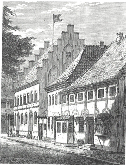
Fig. 2. Rådhuset set fra nordøst. Udsnit af xylografi efter tegning af Magnus Petersen, 1871. Bemærk den lille bindingsværksbygning ved nordgavlen med spor efter den tidligere port ind til den nordre bods gård.
