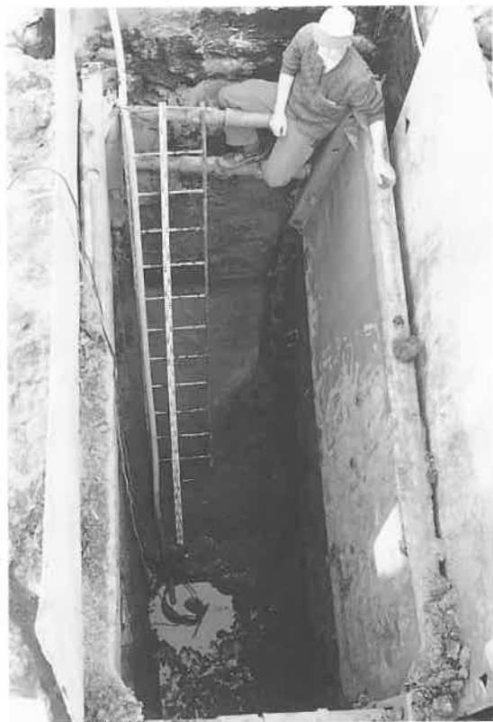
Fig. 3. Profilhul 1 ud for Grønnegade 32 med isat gravekasse. Stadiet viser, at der er 4 m fra manden og ned til spanden i bunden af profilhullet. Yderligere godt 2 m skal lægges til, før man når gadeniveau. Foto: Hans Skov.
