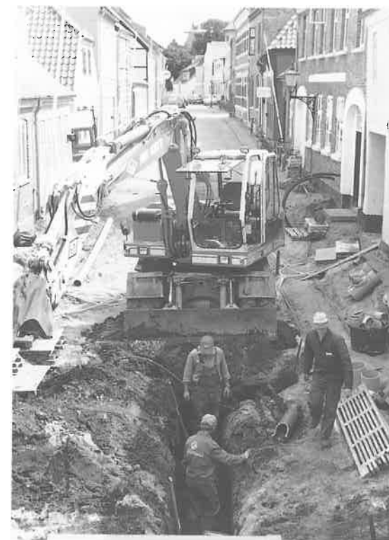
Fig. 2. Kloakgrøften i Grønnegade set fra nord. Den nye grøft er blot 1 m bred og følger slavisk den gamle kloakgrøft. Foto: Hans Skov.
