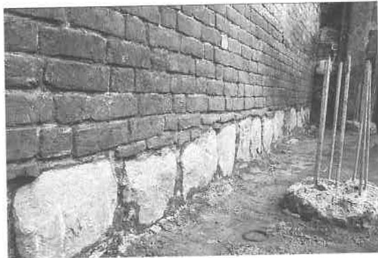
Fig. 5. På det synlige øverste kampestenslag følger nøjagtigt tilpassede teglstensskifter: Greifswald, brandmur Lange Straße 49/47, ca. 1270-80. Foto: André Lutze.
