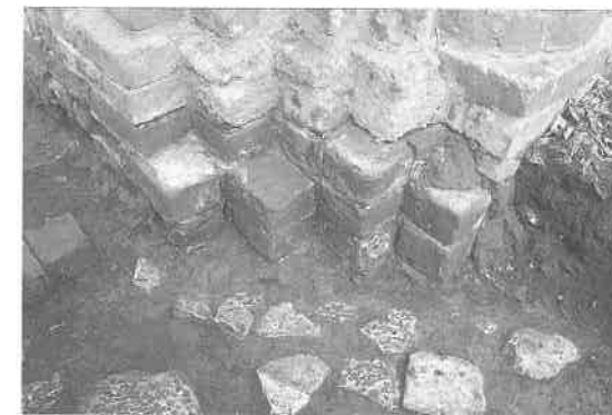
Fig. 2. Fundamentsgrøftens fyld dækkedes med en spinke brolægning af flade kalksten. På et teglstensbrokkelag opmuredes teglstenspiller: Cistercienserklostret Eldena ved Greifswald, ca. 1230-40. Foto: André Lutze.
