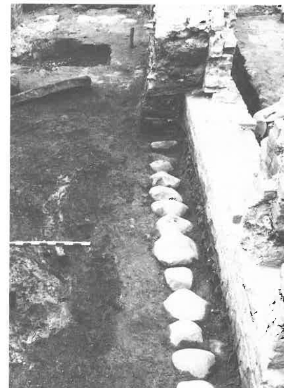
Fig. 12. Kampsten lagt ved siden af murfoden som en belastning og sikring af fundamentsgrøftens fyld: Stralsund, Wasserstraße, kort efter 1382. Foto: Birgit Kullessa/Kulturhistorisches Museum.
