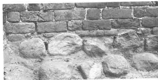
Fig. 6. Greifswald, Rakower Straße 9, baggavl, ca. 1270: Den nøjagtige tilpasning svarer eksempelvis til Markt 14 (fig. 3), men de første tegl er sat i sand. Foto: André Lutze.
