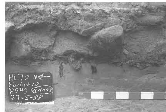
Fig. 7. Et fundament fra Lybeck: brandmur Fischstraße 10, ca. 1280-90, som sammen med sandlaget under rulleskiftet svarer til de Greifswaldske eksempler fra 1300-tallet. Foto: V. W./Amt für Archäologische Denkmalpflege.
