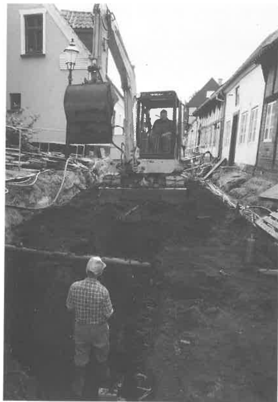
Fig. 2. Den lille gravemaskine på arbejde i Præstegade, set fra nord. Efter grøften var gravet, blev det vores tur til at registrere og udgrave. Da vi var færdige, blev de nye kloakrør lagt. I forgrunden ses Verner, og i maskinen sidder Arne. Foto: Lars Chr. Bentsen.
