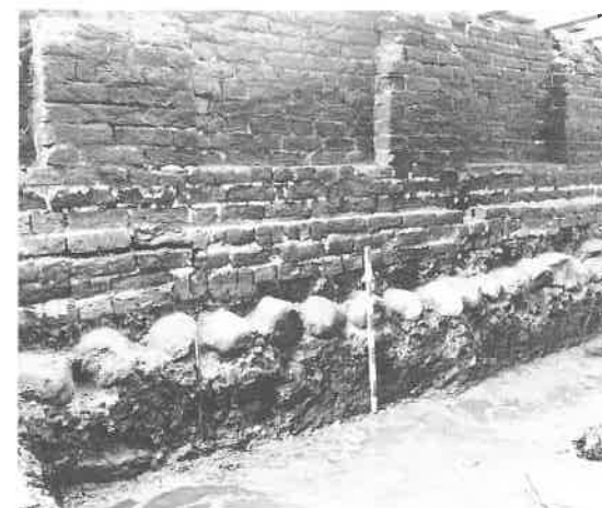
Fig. 9. Et typisk syn under Stralsunds 1300-tals brandmure: teglstensbrokker, mørtel og ler spredt ud over kampestenslaget, derpå de første tegl som rulle- eller kopskifte, overhældt med mørtel. De nederste skifter, uden klart forband, træder lidt frem. I murværket ses de typiske piller, som oprindeligt bar nogle fladbuer: Wasserstraße 55/56, omkring 1330. Foto: Birgit Kulessa/Kulturhistorisches Museum.
