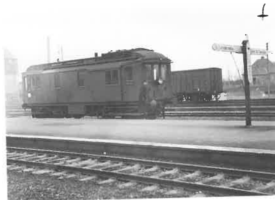
Fig. 10. Dieselelektrisk lokomotiv litra MT fra 1927. Sådanne lokomotiver var den typiske trækraft på sidebanerne syd for Kongeåen i 1930'erne. Bramming, ca. 1939. Foto: James Steffensen/Jens Bruun-Petersens arkiv.
