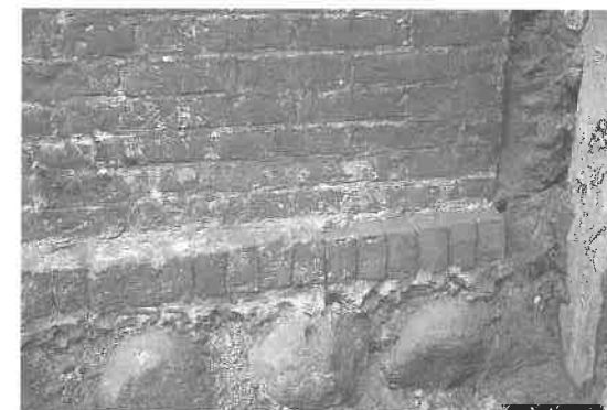
Fig. 8. Kampesten, derpå teglstensbrokker, et sandlag, et rulleskifte sat i sand, og derpå det første mørtellag - sådan ser det stadig ud kort før 1400: Greifswald, Markt 7. Foto: André Lutze.
