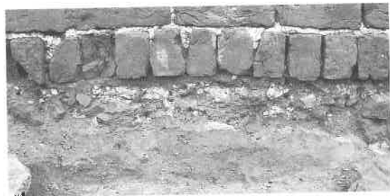
Fig. 4. Et sandlag dækker brokkelaget; teglmurens første mørtellag hældtes over rulleskiftet: Greifswald, brandmur Rakower Straße 8/9, ca. 1330-40. Foto: André Lutze.
