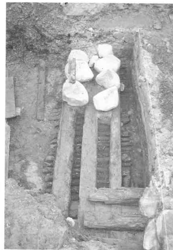
Fig. 16. En brandmurs fundament hviler på en tømmerrist, fra Pläterstraße i Rostock, ca. 1270-90. Foto: Fred Ruchhöft/Amt für Denkmalpflege.
