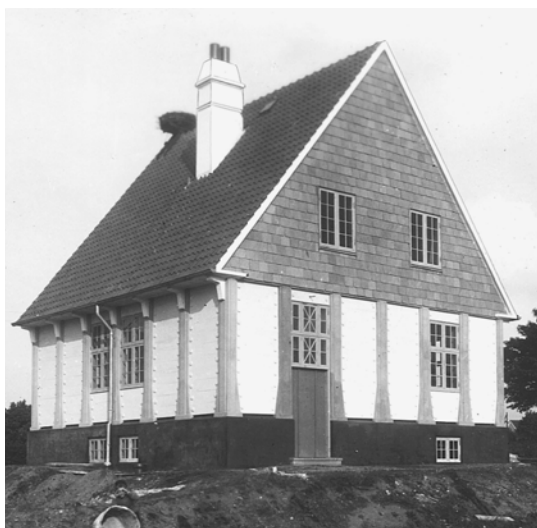
Fig. 10. Huset Sct. Jørgensvej 11 er et elementbygget typehus. Sag nr. 118. Axel Hansen inddrog utraditionelle materialer som jernbeton og vejrbestandige malinger. Huset blev bygget med salg for øje, men der findes vist kun dette ene hus.
