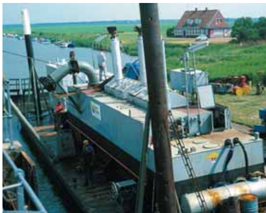
Fig. 12. Sandpumper anvendt i forbindelse med digeforstærkningen 1978-80. Sandpumperen fylder hele kammeret i Kammerslusen. Foto: Linda Christensen.
