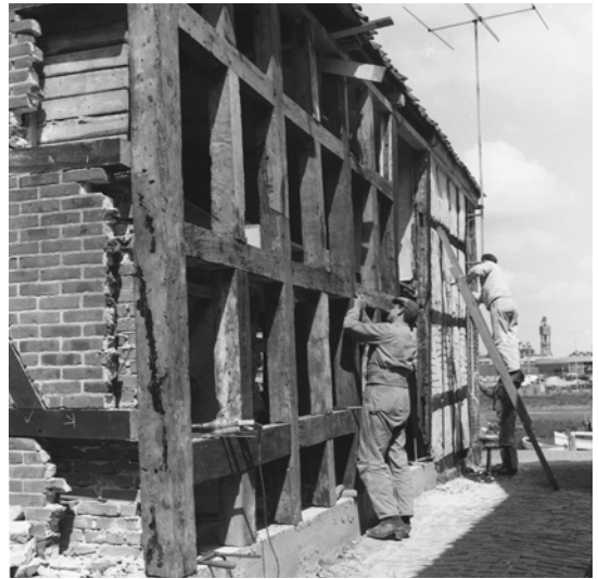
Fig. 6. Skibbroen 13, "Sælhunden". Facaden mod Skomager-slippe, under restaureringen. Store dele af bindingsværket var ødelagt og blev rekonstrueret, som det havde set ud. Foto: Hans Henrik Engqvist. Kilde: ASR 1493 F16.
