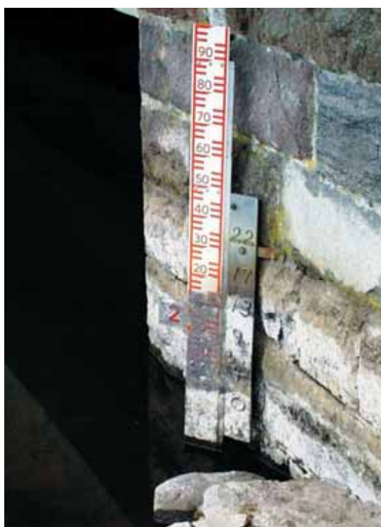
Fig. 6. a) Gammel flodemålspæl i mølledammen ved plejehjemmet "Ved Åen". b) Nye flodemålsmarkeringer på Dagmargadebroen. Foto: Ove Kann.
