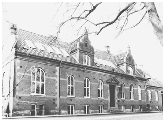
Fig. 9. Balthazar Giørtz' bolig, Sct. Nicolaigade 10. Hovedfløjen var oprindeligt skiferdækket som sidebygningen t.h. og havde vinduer af samme type, hvorover der var udmuret op til undersiden af de buede stik. Foto: Den antikvariske Samling.
