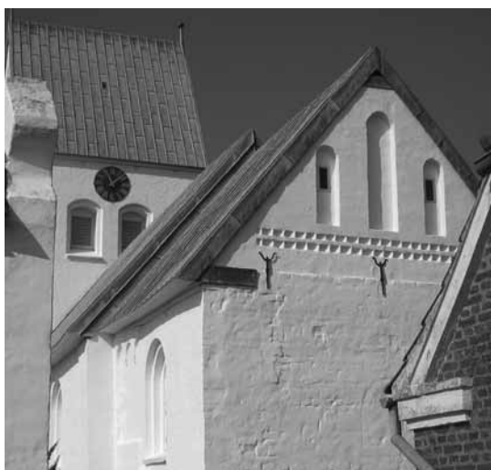
Fig. 16. Kirkerne i Kalvslund (øverst) og Hjortlund (nederst) har begge oven over kortagets vestende en blyklædt afslutning af triumfgavlen, som står lidt øst for skibets bevarede gavls-spærfag. Foto: PKM 2005.
