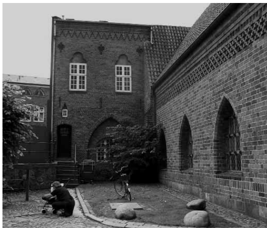
Fig. 9. Den ombyggede facade af den vestre del af bygning A udført af arkitekt H. C. Amberg. Stilen er nygotisk og den oprindelige bygningshøjde er bibeholdt. Foto: Camilla Løntoft Nybye.
