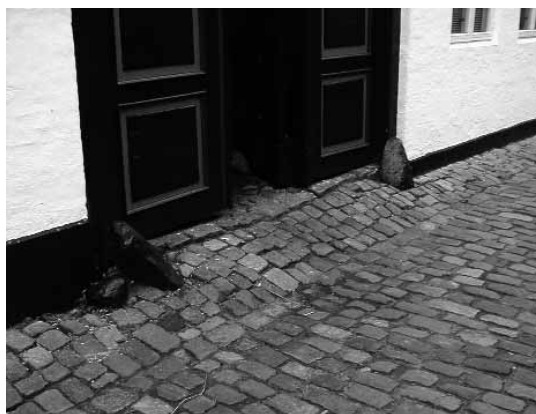
Fig. 4. Ved indkørslen til Fiskergade 2 beskytter afviserstenene med deres skråplacering såvel muren mod skader fra vognhjul, som vognhjulene mod skader fra sammenstød med mur og afviserstenen selv. Foto: Erik. B. Fisker.
