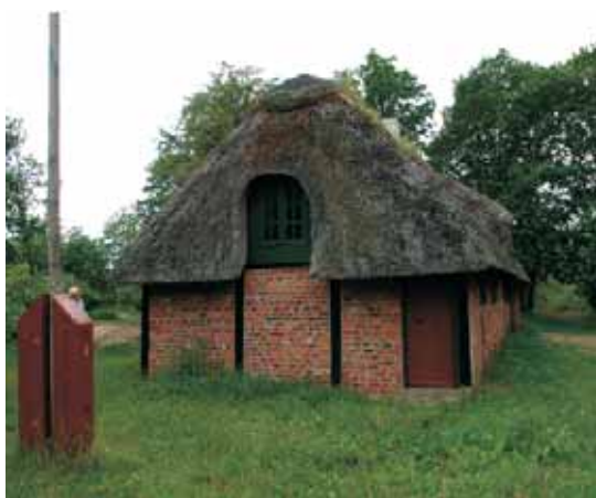
fig. 9. Billedet til venstre er taget umiddelbart før, huset fik lagt nyt stråtag på i 1987/88. I østgavlen ses stalddøren, over hvilken der var anbragt et fanggitter, som i tilfælde af ildebrand skulle hindre taget i at styrte ned foran døren og derved spærre udgangen 6 . Ved udskiftningen af taget fjernede man dette gitter; tilsvarende skete med gitteret over døren på sydsiden. Arkensgabene på øst og nordsiden blev erstattet af kviste, ligesom valmen på vestgavlen fik påsat en kvist. For at få plads til disse ret store kviste blev taget udvidet. I forening med det store udhæng kom taget derved i høj grad til at dominere bygningen. Da man ville udnytte loftsrummet, var det nødvendigt at indsætte to stolper i østgavlen til at bære loftet. Indgreb, som af mange er blevet karakteriseret som ret hårdhændede. Vestgavlen er helt uden bindingsværk. Her understøtter indvendige bjælker og skillemure loftet. Fotos: Tilhører Flemming Hausted, Esbjerg.
