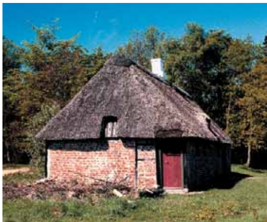
fig. 9. Billedet til venstre er taget umiddelbart før, huset fik lagt nyt stråtag på i 1987/88. I østgavlen ses stalddøren, over hvilken der var anbragt et fanggitter, som i tilfælde af ildebrand skulle hindre taget i at styrte ned foran døren og derved spærre udgangen 6 . Ved udskiftningen af taget fjernede man dette gitter; tilsvarende skete med gitteret over døren på sydsiden. Arkensgabene på øst og nordsiden blev erstattet af kviste, ligesom valmen på vestgavlen fik påsat en kvist. For at få plads til disse ret store kviste blev taget udvidet. I forening med det store udhæng kom taget derved i høj grad til at dominere bygningen. Da man ville udnytte loftsrummet, var det nødvendigt at indsætte to stolper i østgavlen til at bære loftet. Indgreb, som af mange er blevet karakteriseret som ret hårdhændede. Vestgavlen er helt uden bindingsværk. Her understøtter indvendige bjælker og skillemure loftet. Fotos: Tilhører Flemming Hausted, Esbjerg.
