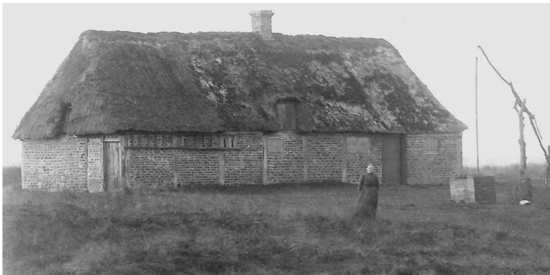
Fig. 2. Huset set fra nord omkring 1900 med Dorthea Frandsen i forgrunden. På nord- og østsiden ses de såkaldte arkensgab, dvs. luger, hvor hø og korn kunne forkes ind på loftet. Bemærk den intakte vippebrønd foran huset 2 . Over jorden har brønden en brøndkarm. Hejseværket består af en brøndtveje med en tværliggende vippestang, der er fastgjort til brøndtvejen ved hjælp af en tværpind. Vippestangen har en kontravægt i den tykke ende og i den tynde ende et hængselsled til brøndstaget. For enden af brøndstaget sidder brøndkrogen med et lukketøj, som hindrer vandspanden i at falde af. Foto: ASR M8068.
