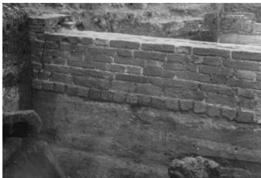
Fig. 2. Byhus i Grønnegade under udgravning. Under murværket ses de fine, vandrette sandlag, der udgør sandfundamentet. Foto: SJM.
