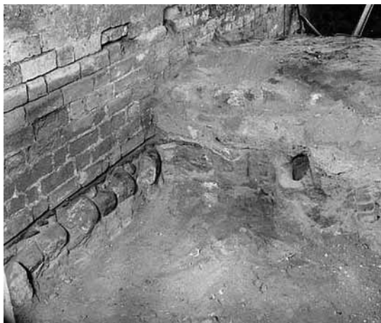
Fig. 27. Munkesalens nordvæg med spinkelt stenfundament. Set fra SV. Foto: Johs. Hertz 1960.
