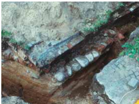
Fig. 20. Østfløjens østmur. Tv. tværsnit i fundament. Th. frigravning langs fundament. Set fra SØ. Foto: Frede Gotthardsen 1990.
