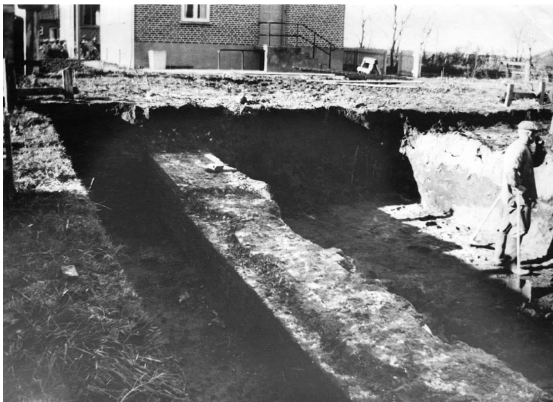
Fig. 2. Murforløbet fra 1934, der blev fundet under udgravning til huset på hjørnet af Skt. Clemens Gade og Skt. Laurentii Gade. Fotoet er taget fra øst.
