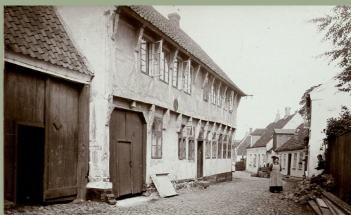
Eksempler på restaureringer af byhuse i Ribe fra 1957 til 2009 – og eksempler på skæmmende kommunale afgørelser i det bevaringsværdige bybillede
