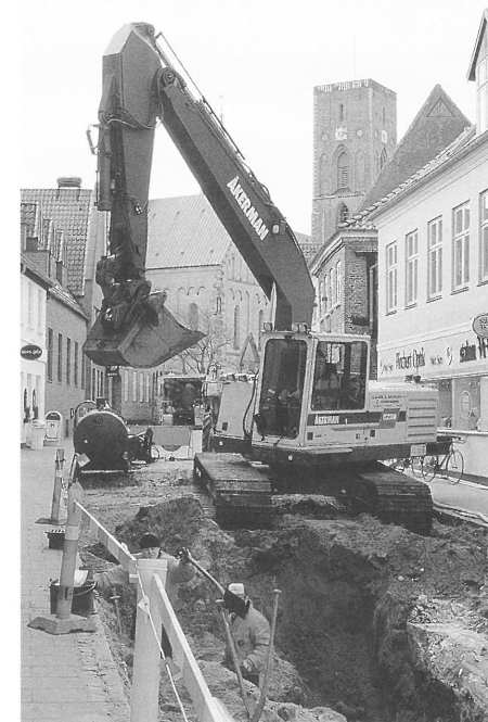
Fig. 2. De store gravemaskiner prægede bybilledet i foråret 1996. Gravearbejdet blev udført af entreprenørfirmaet Clausen og Mikkelsen. Foto: L. Andersen.
