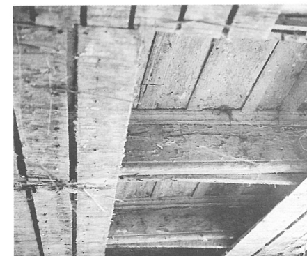
Fig. 14. Et glimt af bindingsværkslængens oprindelige bræddeloft over første stokværk med profilerede dækklister og hulkehlslisters langs de profilerede tværbjælker. I forgrunden bjælke VIII og bagest bjælke VII. Man har med påsømmede lægter på siden af bjælkerne gjort underlaget for loftet på disses underside vandret på trods af tværbjælkerens nedsynkning på midten. En anden metode er at behugge bjælkerne på undersiden, ofte med helt op til ca. 10 cm. Foto: PKM.
