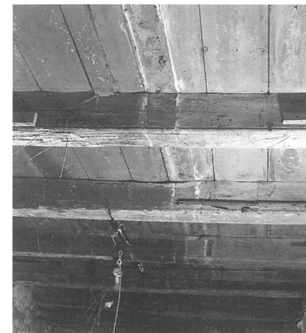
Fig. 16. Undersiden af de tværbjælker, der blev lagt ind i det middelalderlige stenhus, da dette kort før 1600 sammenføjedes med den nye bindingsværkslænge mod syd. I forgrunden bjælke 2 fra nord. På bjælker og loftsbrædder ses som to parallelle lyse streger sporet af den langsgående skillevæg i det nye gavlhushets forreste del, jvf. fig. 3. Selve vægsporet står med samme rødbrune farve som rummet mod øst, mens rummet mod vest har blågrå loftsbe-maling. Foto: PKM.
