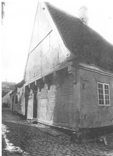
Fig. 2. Den frie gavl mod Skomagerslippe som den fremtræder siden Axel Hansens istandsættelse i 1928. Foto i Antikvarisk Samling.
