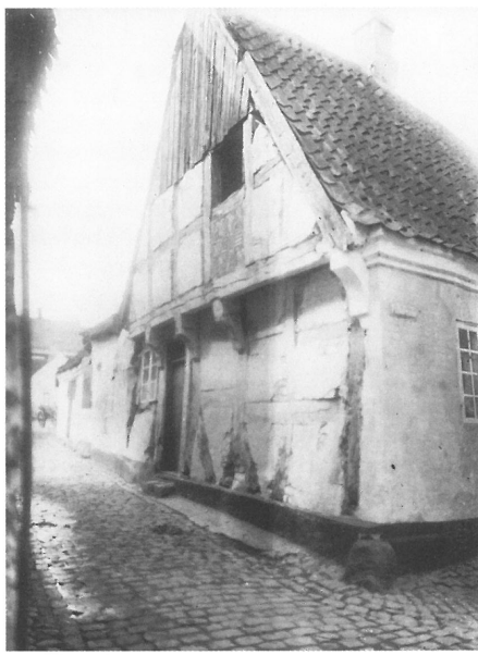
Fig. 4. Foto fra før Axel Hansens ombygning. Der er ingen stolpe i fag nr. 2, men derimod et løsholt mellem de flankerende stolper. Derfor er der heller ingen spor i overgangsfodens underside efter en falsk bjælkeende. Over løsholtet - der sidder lavere end de øvrige - har der formentlig været et vinduesparti. Foto i Ribe Lokalkarkiv.
