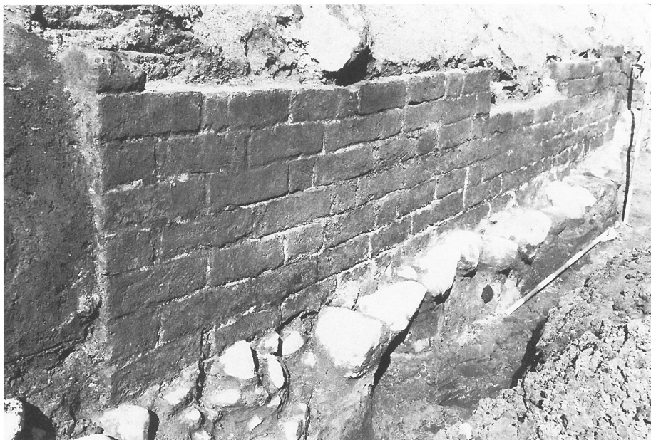
Fig. 8. Nordmuren i portrummet set fra vest. Bemærk fundamentet af kampesten. Foto: Hans Skov.
