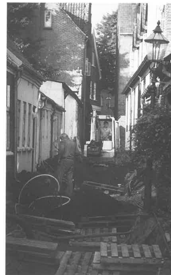
Fig. 6. Mini-gravemaskinen på arbejde i Peder Dovns Slippe. Foto: Claus Feveile.
