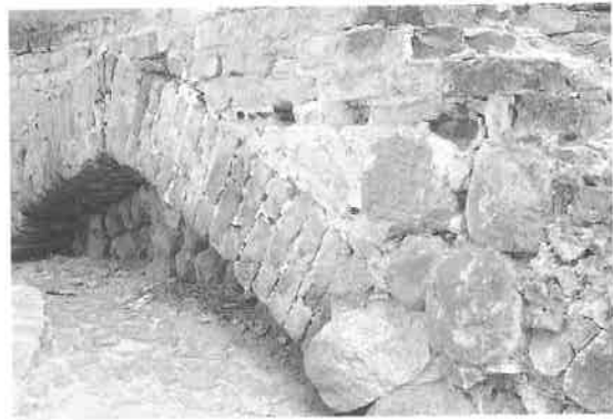
Fig. 13. "Jordbue" under borgen Stargards ringmur, ca. 1260-70. Oprindeligt skjult under bermen - undermuringen er senere. Foto: Jens Christian Holst.
