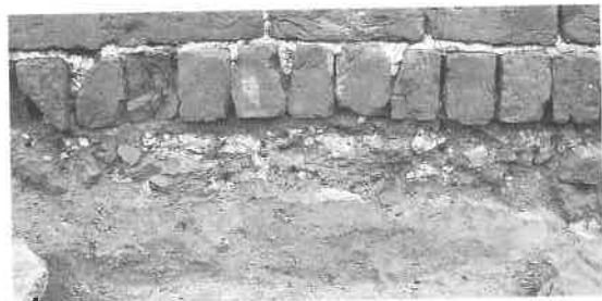
Fig. 4. Et sandlag dækker brokkelaget; teglmurens første mørtellag hældtes over rulleskiftet: Greifswald, brandmur Rakower Straße 8/9, ca. 1330-40. Foto: André Lutze.
