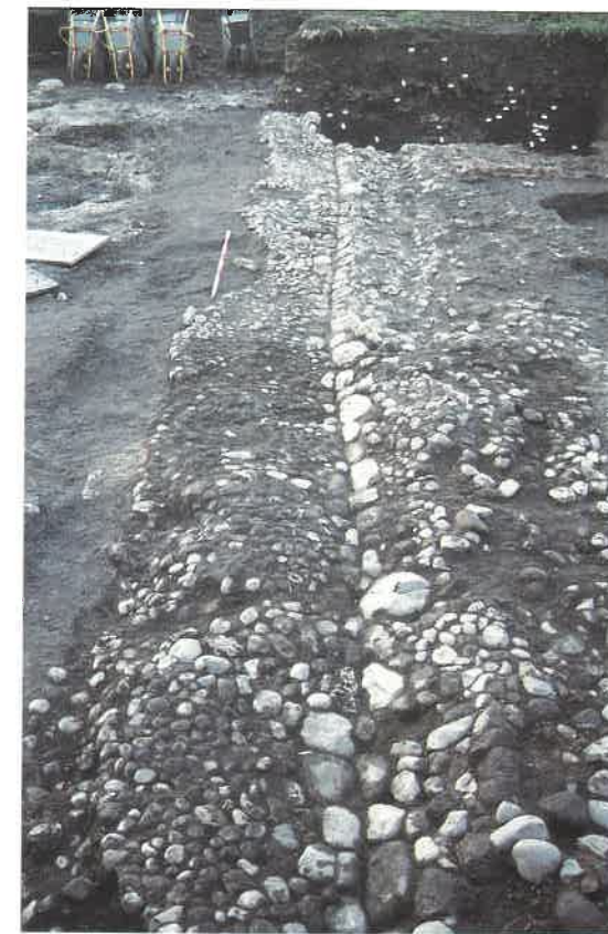
Fig. 5. I løbet af 1300-årene blev vejen brolagt. I midten ses rendestenen, der er lagt i større kampesten. Foto: Lis Andersen.
