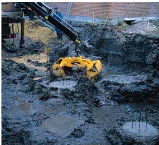
Fig. 17. Pilotering på grunden d. 6. december 1999. Foto: Marie F. Klemensen.
