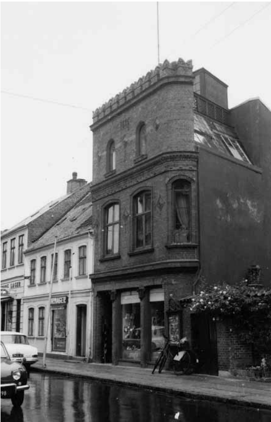
Fig. 20. Dagmarsgade 9. Fotograf Bodil Hauschildts hus med ateliervindue i den skrå tagflade og tagterrasse ovenover. Foto: Den antikvariske Samling.
