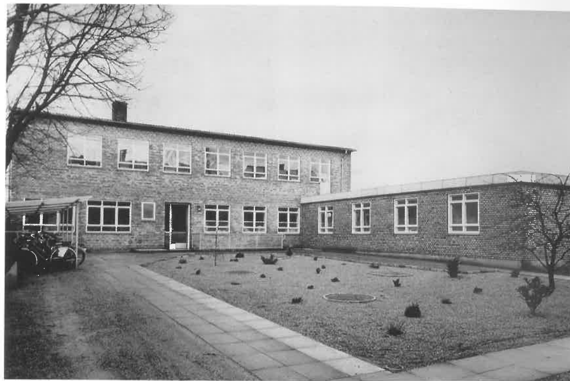
Fig. 11. Det samlede fabriksanlæg på Tangevej. Bagbygningen fik en ny etage sat på i 1957. Den armerede bygning til højre, der skulle rumme regntøjsproduktion, opførtes i 1961. Foto tilhører Hanne Keldorff.
