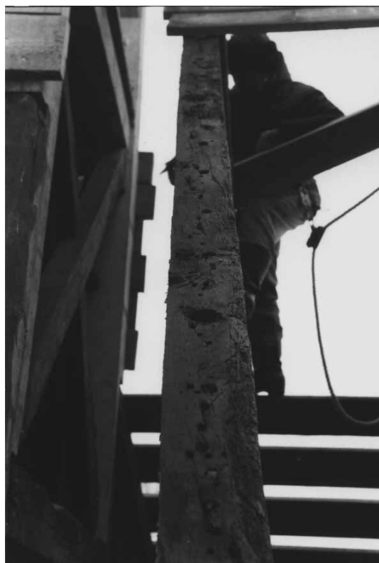
Fig. 12. Kalvslund Kirke, søndre spær i spærfag 4. På ydersiden af spæret række af naglehuller, deraf nogle med afbrudte nagler samt sømhuller efter blybrædder. Foto: PKM 1993.
