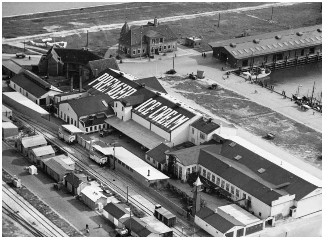
Fig. 1. Premier Is blev i 1927 bygget som den første iskremfabrik i Esbjerg. Ud over iskrem fremstilledes is til fiskeindustrien og fabrikken rummede mod gårdsiden flere mindre virksomheder samt fryserum til grøntsager og kød. Fabrikken blev senere overtaget af Hjem IS. Billedet er fra ca. 1950. Foto: Esbjerg Byhistoriske arkiv.
