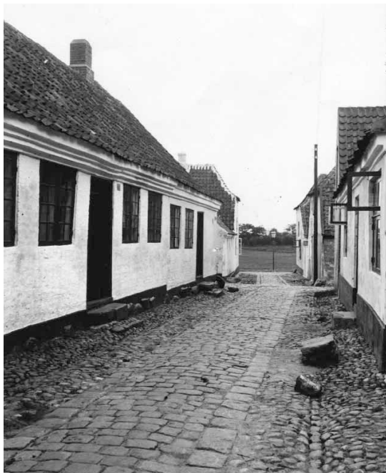
Fig. 8. Bredeslippe, 1917. Gaden har bevaret sin belægning stort set uændret frem til i dag, og er vel nok Ribes flotteste brolægning. Efter Matthiessen 1983, s. 44.
