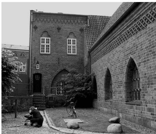
Fig. 9. Den ombyggede facade af den vestre del af bygning A udført af arkitekt H. C. Amberg. Stilen er nygotisk og den oprindelige bygningshøjde er bibeholdt. Foto: Camilla Løntoft Nybye.
