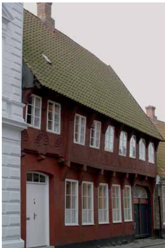
Fig. 1. Huset i Sønderportsgade set fra nord. Forskellen i bindingsværket viser tydeligt, at det drejer sig om to huse, der på et tidspunkt er bygget sammen til ét. De to østlige fag er resterne af et gavlhuis fra 1585-95 genopført efter bybranden 1580, medens de syv vestlige fag stammer fra tiden omkring 1600, opført på tomten for Niels Thamsen Kræmmers hus. Det er under gulvet her, brandlaget med de mange kakler befinder sig. Foto: Ole Kristiansen.
