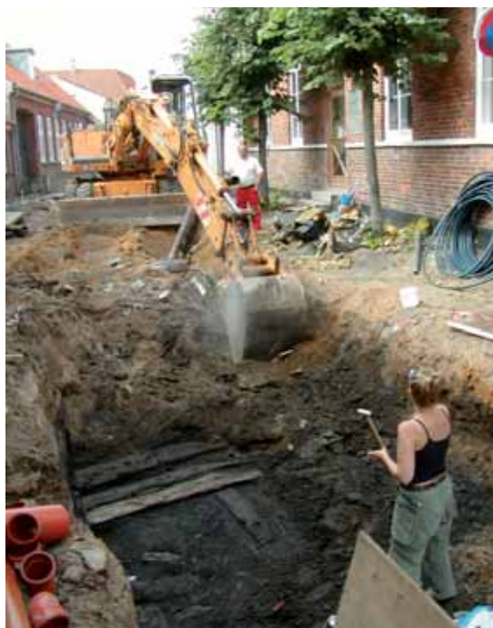
Fig. 3. Typisk arbejdsituation i Sønderportsgade. Mens arkæologerne arbejder med registrering af en rest vejbelægning fra første del af 1200-årene er gravemaskinen for en stund rykket over i gadens nordside, hvor 1960'ernes støbte fjernvarmekasser er ved at blive brækket op. Få timer senere er registreringen overstået, kloakken udskiftet, og gravemaskine og arkæologer rykker seks meter mod vest og gentager proceduren. Foto: Den antikvariske Samling.
