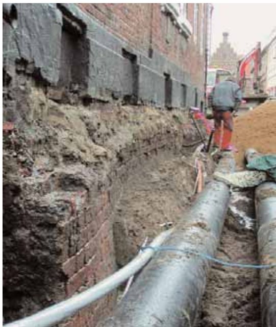
Fig. 15. Det er længe siden, at murværket under kannikerresidensen Snagdal var lige. De omgivende organiske lags gradvise nedbrydning har resulteret i sætninger i det underliggende sand- og brokkefundament, så murværket i dag bugter sig som en slange. Foto: Den antikvariske Samling.
