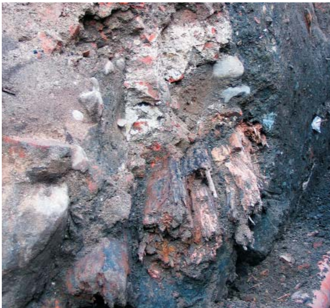
Fig. 21. På billedet af den skråt gennemskårne sydmur i kælderen Hus 7 ses, at murværket hviler på et lag af langsgående stammer, såkaldt slyngværk, der vistnok bestod af fyrrestammer. På den måde har man søgt at skabe et solidt fundament for kælderen, der er gravet ned i bløde, organiske kulturlag. Stammerne var efter små 700 år i jorden stadig forholdsvis friske. Foto: Den antikvariske Samling.
