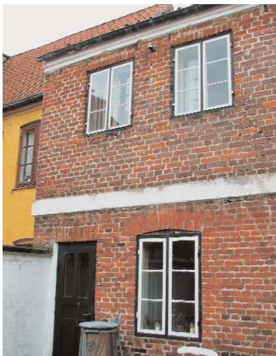
Fig. 12. Gårdsiden af Sortebrødregade nr. 3 i Ribe. Ruden har siddet i vinduet på 1. sal til venstre. Foto: SJM.
