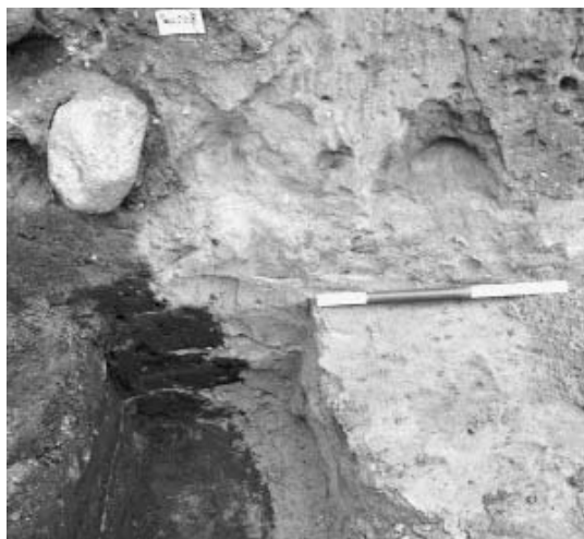
Fig. 12. Opbygning af sandfundament fra gråbrødreklostret i Horsens. De tynde sandlag i den mørke kulturjord viser, at man har opbygget fundamentet samtidig med at terrænet er blevet hævet. Situationen ligner meget den, der er dokumenteret ved Korsbrødregård. Foto: Hans Krongaard Kristensen.
