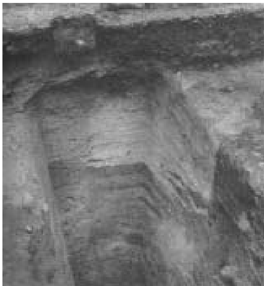
Fig. 14. Her ses den tydelige stratigrafi mellem de to fundamenter under Løgum Kloster kirkes søndre sideskib. Så tydelige stratigrafiske observationer kan kun i yderst sjældne tilfælde gøres i traditionelle stenfundamenter. Efter Sterum 1977.
