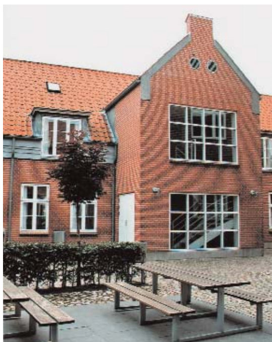
Fig. 7. Fritliggende bygning i Gravsgade, bagside.
